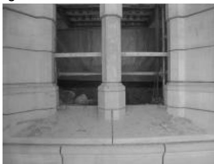
AUßENSANIERUNG NIMMT GESTALT AN
